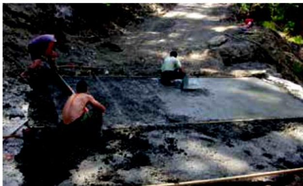
Mise en œuvre d'un radier en béton armé en Savoie
